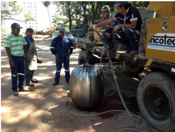
Momento en que se procede a inflar el expand body para la prueba. En la foto se ven operarios y máquinas de Incotec, firma que posee la licencia en Santa Cruz, Bolivia. / ABC Color
